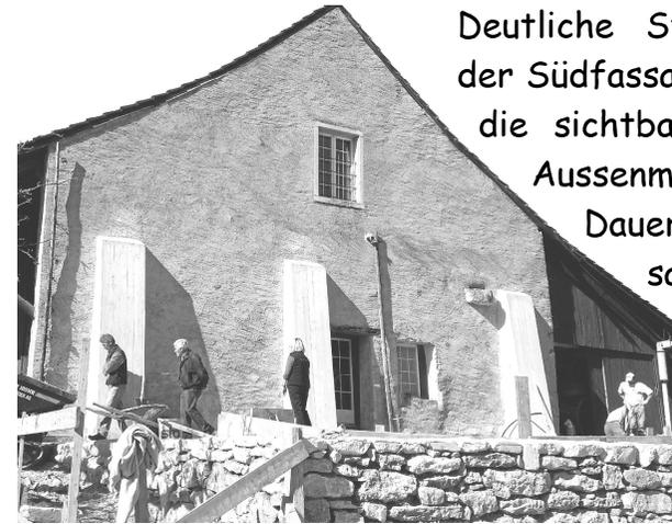
Deutliche Stützmassnahmen an der Südfassade. Hintergrund war die sichtbare Instabilität der Aussenmuer und damit die Dauerhaftigkeit des gesamten Gebäudes.
